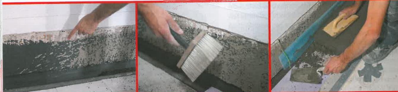
**Schritt 1+2** Aufbringung eines Haftvermittlers auf die Abdichtung
